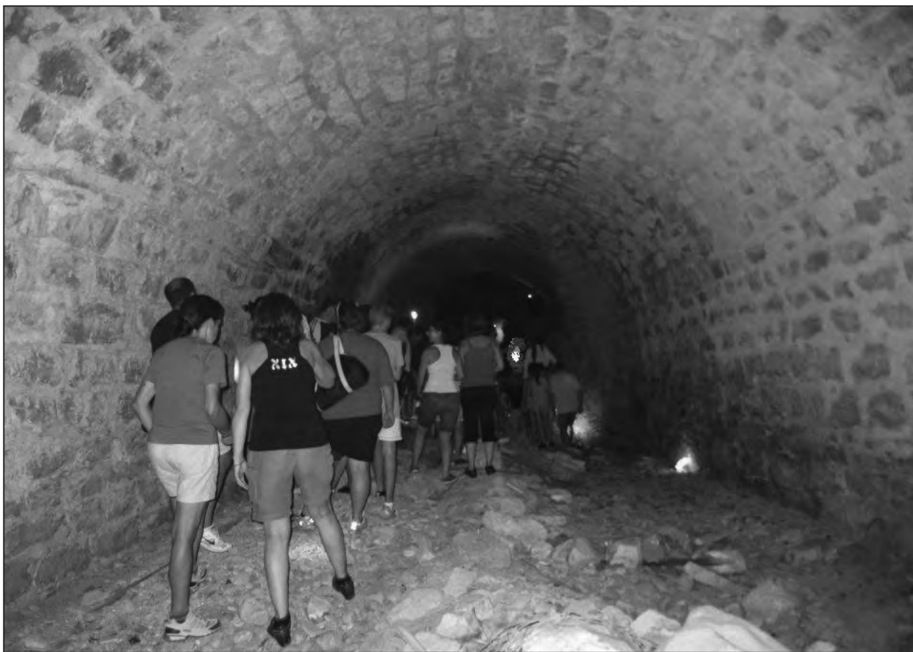
Figura 48. Santa Magdalena de Polpís. Puente en el Camí dels Romans en su cruce con el Barranc de la Carrera . Vista inferior.
