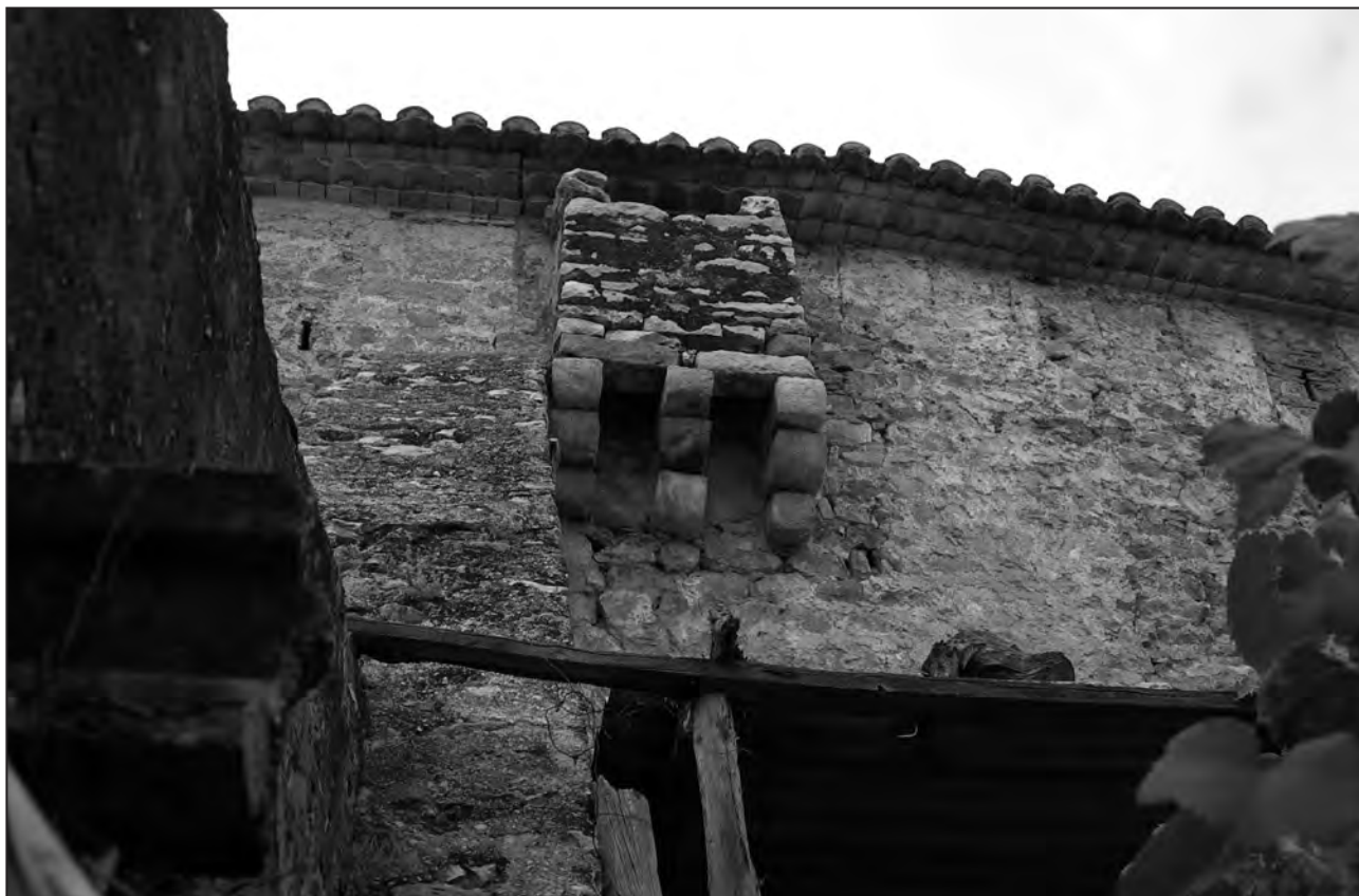
Figura 57. Torre Blanca. Matacán sobre la puerta de la ermita de S. Francisco (Foto A. Rufino).
